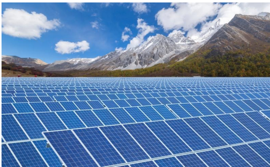
8-сурет - Huanghe Hydropower Hainan Solar Park
